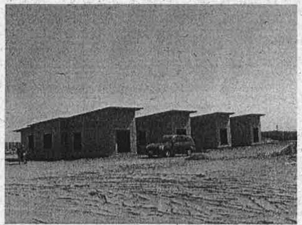
Fotografía N° 2: Vista del estado actual de las viviendas con mayor grado de avance en proyecto Pampa Ilusión, comuna de Huara.
