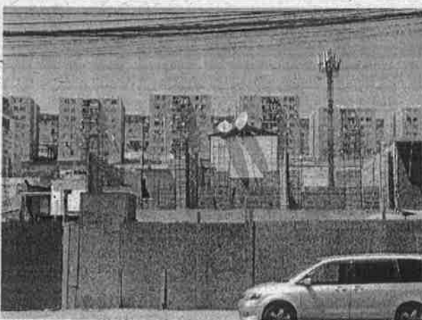
Fotografía N° 7: Estado exterior de viviendas actualmente resciliadas y que se ubican en calle Av. Los Cóndores, a la espera de reconstrucción de obras.
