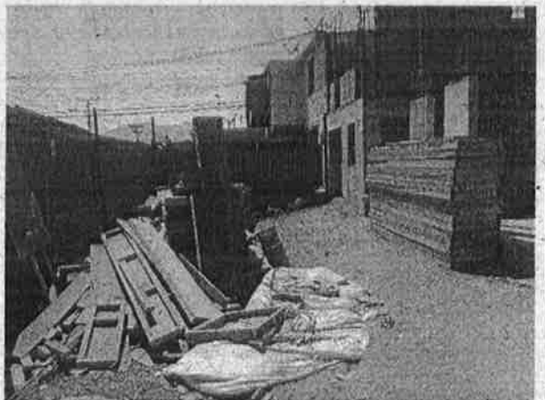
Fotografía N° 8: Estado actual de viviendas que fueron resciliadas y que se ubican en calle Av. Los Cóndores, a la espera de reconstrucción de obras.
